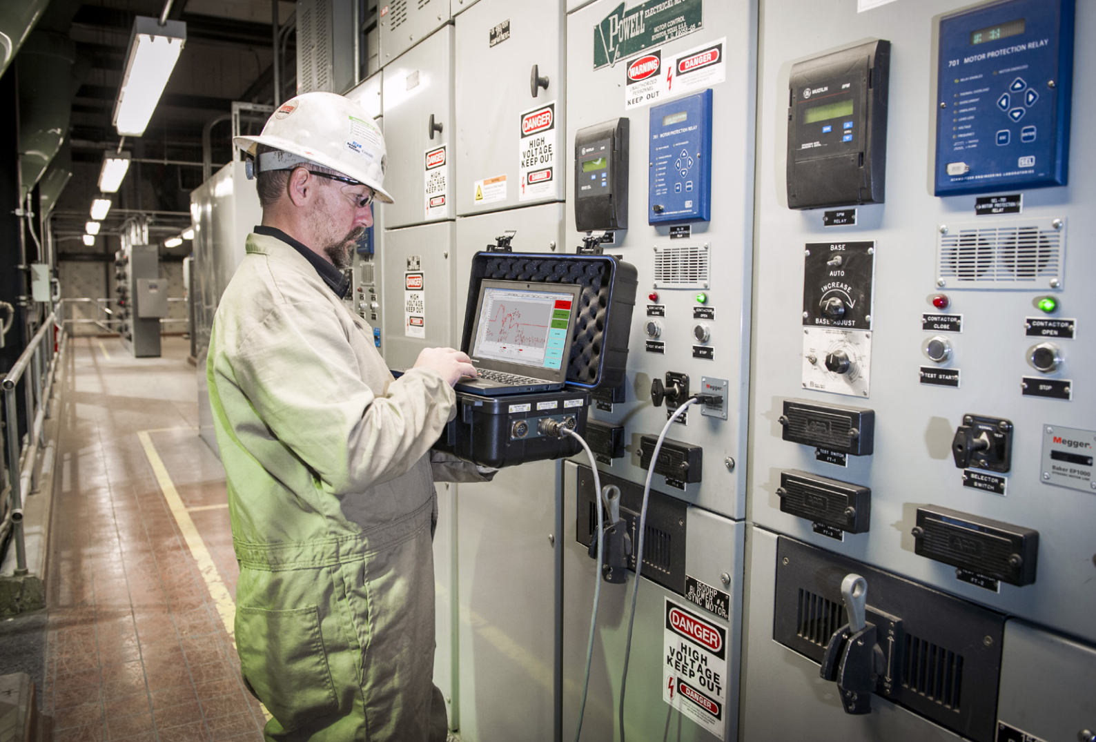
Technik pracující s analyzátozem EXP4000 připojeným k rozváděči pomocí EP1000.
